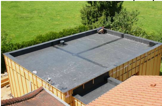
EPDM ou membrane réfléchissante
