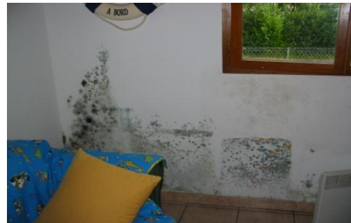
Front d'eau visible sur la face extérieure d'un mur et contaminations résultantes dans la chambre d'enfant attenante. Cause : Remontées capillaires
