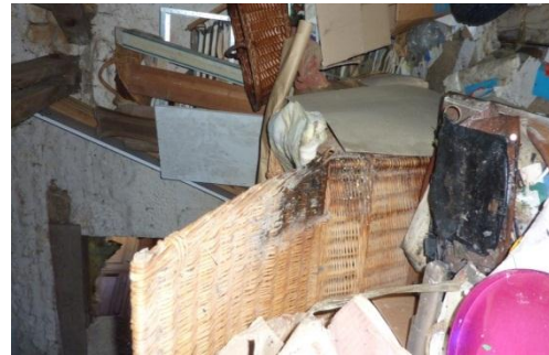
Endommagement de la charpente et des articles stockés dans le grenier du fait d'infiltrations des eaux de pluie. Cause : Envol d'une partie de la toiture lors d'une tempête
