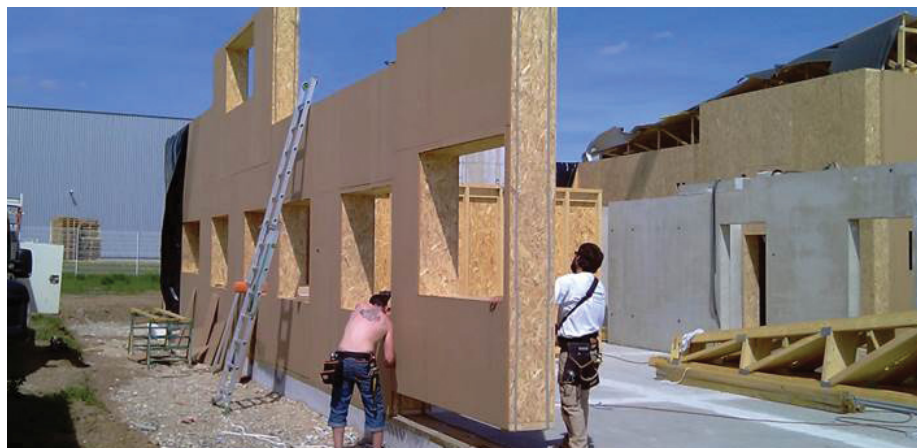
Montage des caissons
