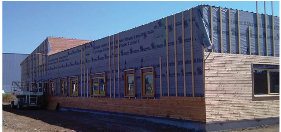
Montage des caissons paille
