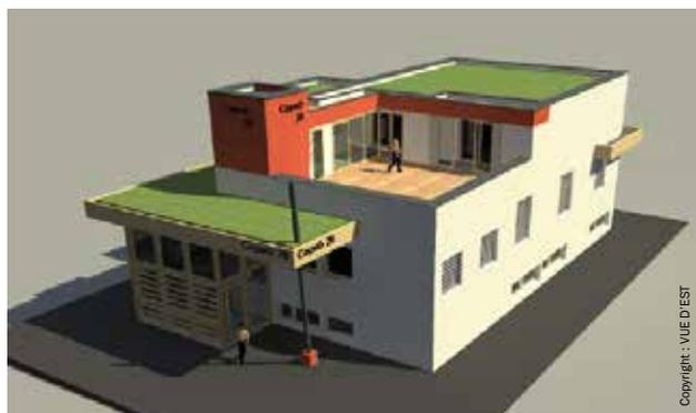
Réhabilitation d'un bâtiment tertiaire de 618 m<sup>2</sup> sur 3 niveaux à destination du nouveau siège de la CAPEB de la Drôme. Le projet vise un niveau de performance proche du bâtiment passif. La priorité va se porter sur le traitement de l'enveloppe et sur le choix de solutions techniques performantes.
