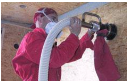
Insufflation sous pression (Source Isofloc)
