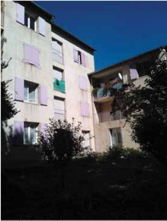
Un immeuble de logement social
