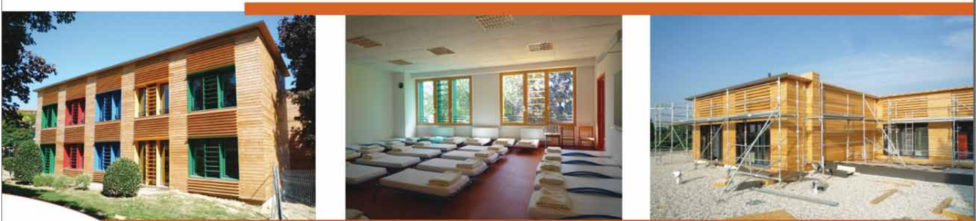
Réhabilitation des phases 1 et 2 : salles de classe présentant la même typologie et travaux de réhabilitation de même nature que pour les classes des phases 3 et 4
