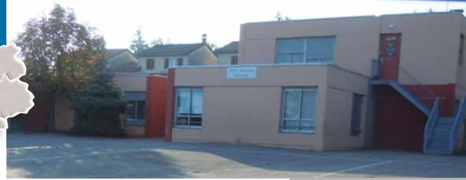
Bâtiment avant rénovation
