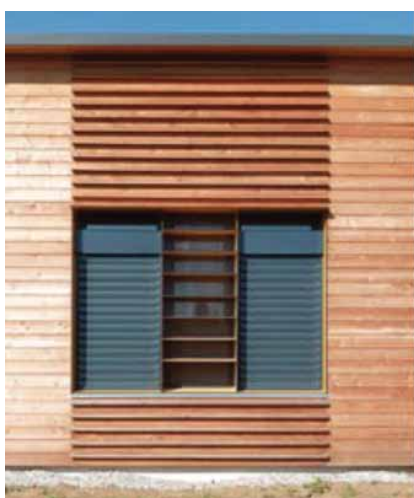
Intégration confort lumineux, éclairage, ventilation naturelle et anti-intrusion - groupe scolaire de Dardilly - TEKHNE
