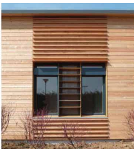
Intégration confort lumineux, éclairage, ventilation naturelle et anti-intrusion - groupe scolaire de Dardilly - TEKHNE
