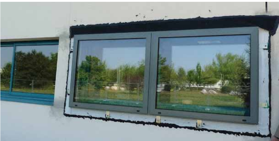
Avril 2011 : pose de la menuiserie témoin et réalisation de deux tests d'étanchéité à l'air dans le bureau. Le premier test permet de localiser et quantifier d'éventuels défauts d'étanchéité à l'air de l'enveloppe puis de les corriger. Le second test est un test de contrôle. Source : M. Cortesi.
