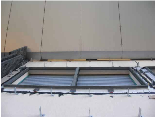
Continuité de l'isolant derrière la casquette (à gauche). Skydome condamné (en haut).
