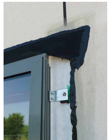
Avril 2011 : pose de la menuiserie témoin et réalisation de deux tests d'étanchéité à l'air dans le bureau. Le premier test permet de localiser et quantifier d'éventuels défauts d'étanchéité à l'air de l'enveloppe puis de les corriger. Le second test est un test de contrôle. Source : M. Cortesi.
