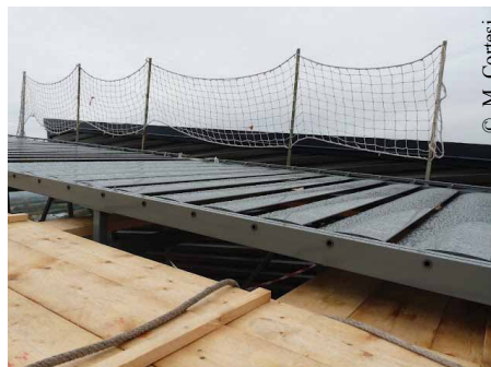
Brises-soleil orientables sur la verrière. Une vigilance a été portée sur leur résistance au vent.
