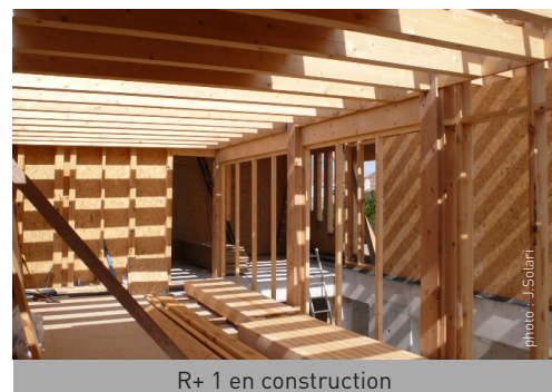
R+ 1 en construction
