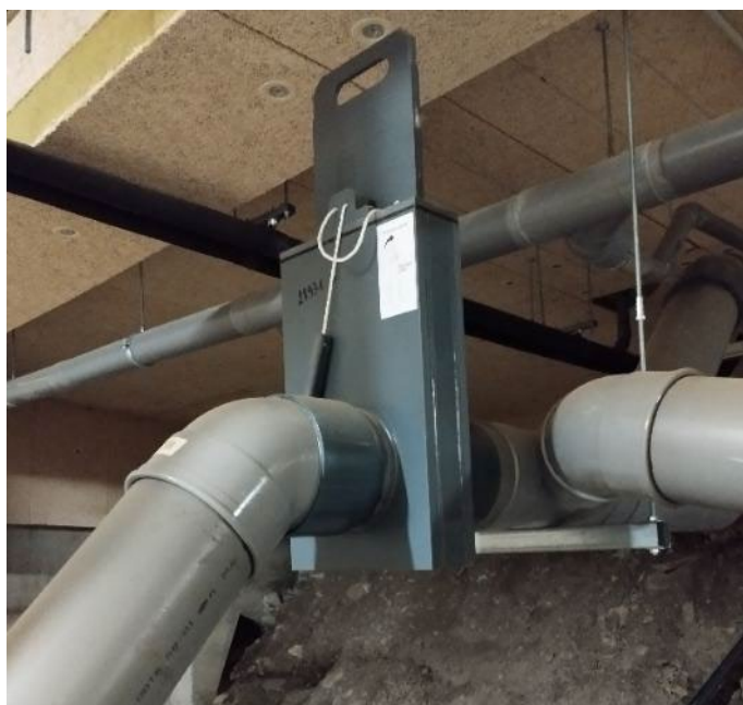
Figure 44 : Photographie de la vanne à guillotine en amont de la cuve et de la canalisation de détournement, visible à droite
