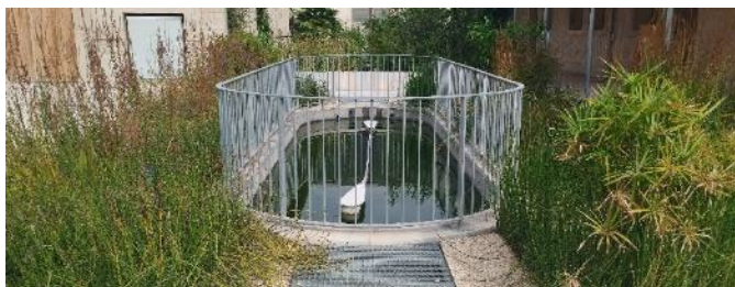
Figure 60 : Bassin d'algues et du filtre hélophyte périphérique
