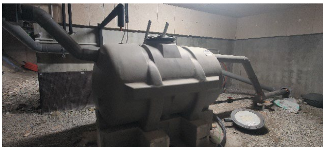
Figure 20 Cuve rigide en PEHD de 2 m³
