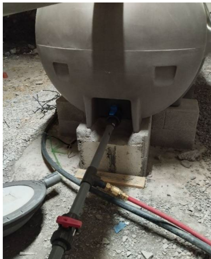
Figure 45 : Photographie du tuyau de relevage de la cuve de récupération en partie basse de celle-ci, en rouge à droite
