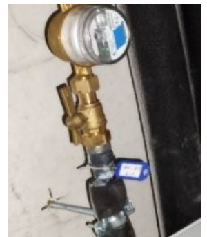
Figure 35 : compteur d'eau de pluie pour 3 logements.
