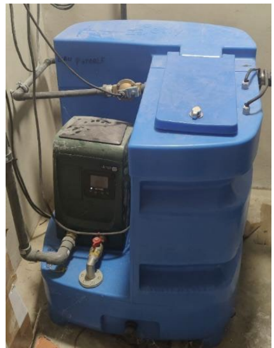
Figure 30 Exemple de système gestionnaire d'eau de pluie disposant d'un système de surpression (boîtier foncé à gauche)
