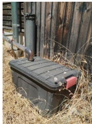
Figure 92 : caisse de filtration des eaux grises issues des lave-linges communs contenant de la paille compressée
