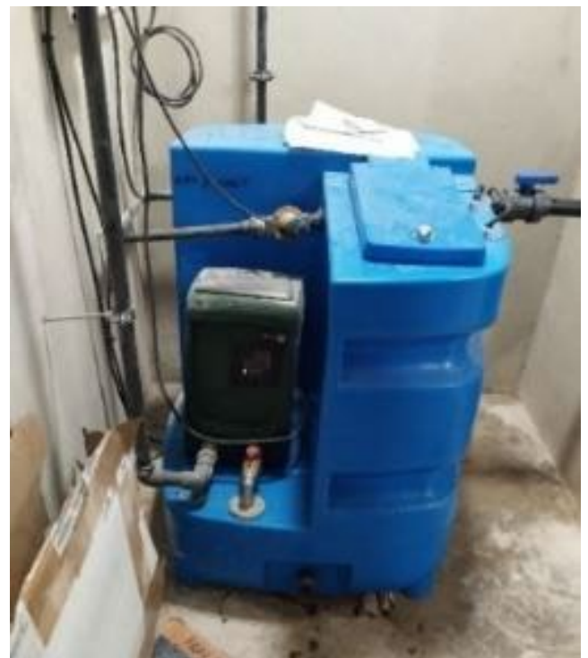
Figure 34 : système gestionnaire des eaux de pluie dans le local technique R-1 du bâtiment A
