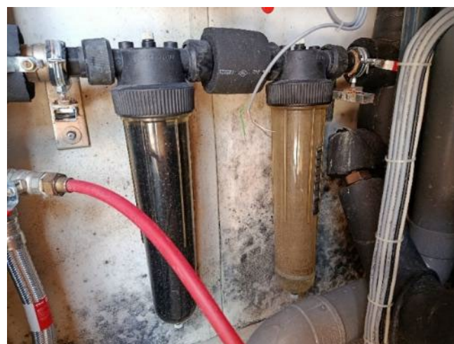
Figure 72 : Dispositifs de filtration en aval de la cuve. Le filtre de maille de 90 µm est à droite, le filtre à charbon à gauche
