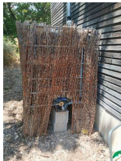
Figure 91 : Une des cuves rigides récupérées à un industriel local, recouverte de canisses.
