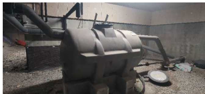
Figure 41 : Photographie du vide sanitaire spacieux, de la cuve de récupération, ainsi que l'échelle donnant accès au trou d'homme situé en partie supérieure de la cuve
