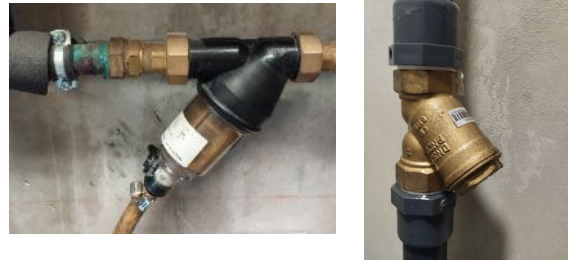
Figure 23 Photographies d'un filtre à tamis avec vanne de purge (à gauche) et d'un filtre à tamis classique (à droite)
