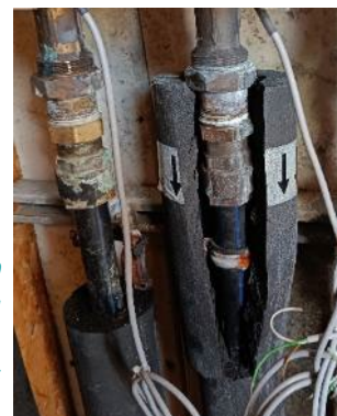
Figure 69 Photographie de 2 tuyaux PEHD à bande bleue, pour l'alimentation en eau potable, avec la bande pas ou peu visible sous l'isolation
