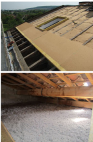
Exemple d'isolation sous (sarking) et sur toiture
