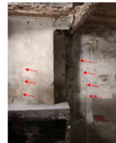
Figure 44 – Niveau R+1 : Fissures verticales (cheminée et mur,
