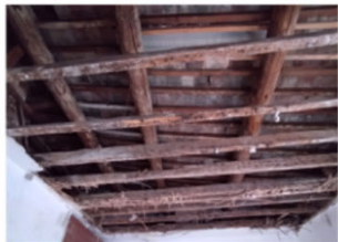
Toiture : poutre - chevron - mailon de couvert
