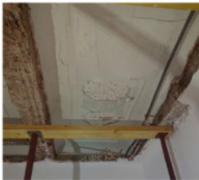
[13] Faux-plafond plâtre mouluré entre poutre R+1
