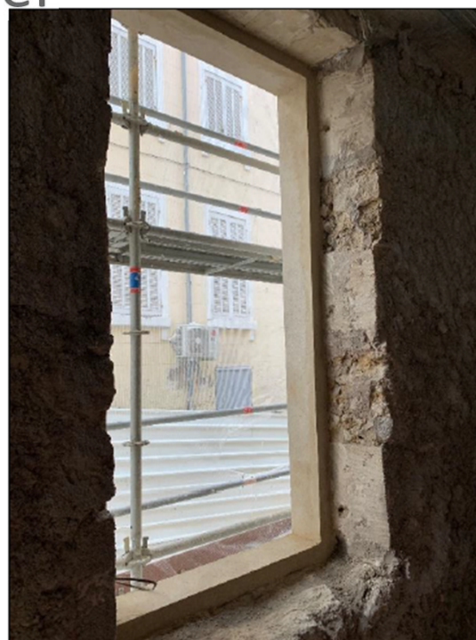
Réalisation de feuillures sur les anciennes baies
