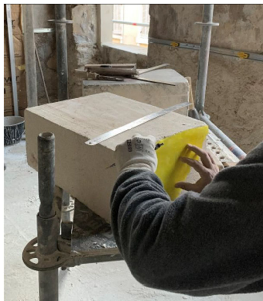
Taille de la nouvelle pierre en remplacement
