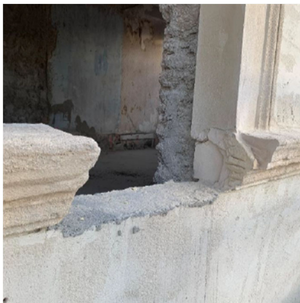
Appui de fenêtre déposé
