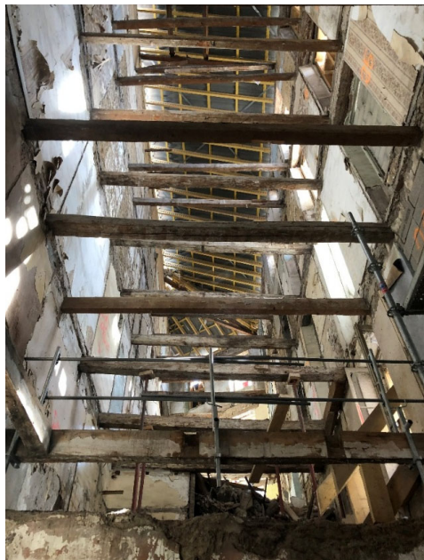
Effondrement de couverture constaté en 2020 à la reprise des études. Purge et mise en place d'une couverture provisoire
