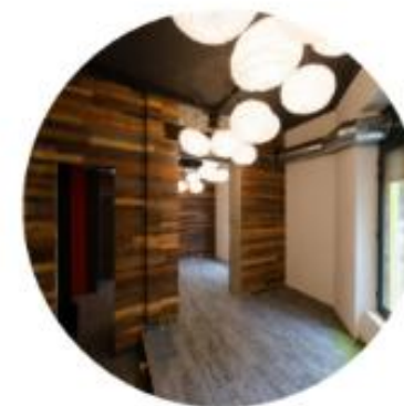
Parement intérieur de réemploi
