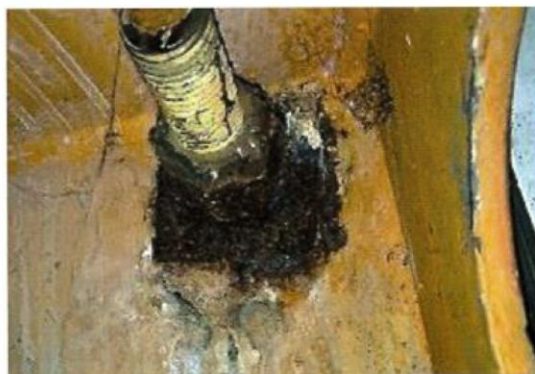
Câble d'ancrage sr pilier béton à reprendre (corrosion et platine) [1]
