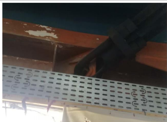
Ancrage des câbles à reprendre (renforcement de platine et gousset [1])
