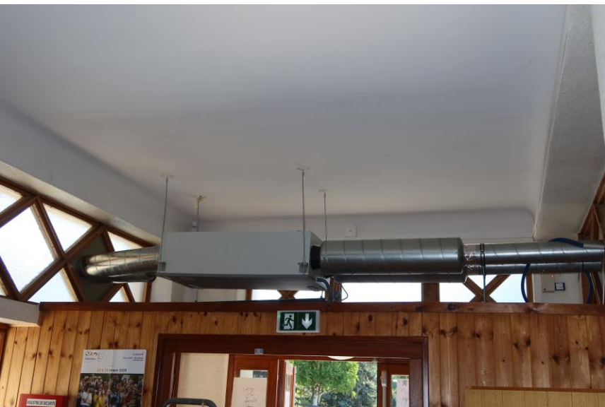
Ventilation double flux au niveau de la bibliothèque et des sanitaires (R+1) - Photo : VOLTHELIOS - JN ANTOINE
