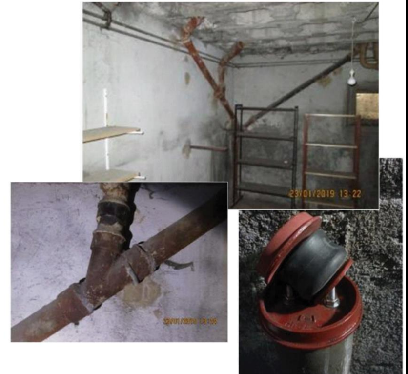
Découpage des anciennes canalisations (au niveau des caves) - fermeture par un joint étanche
