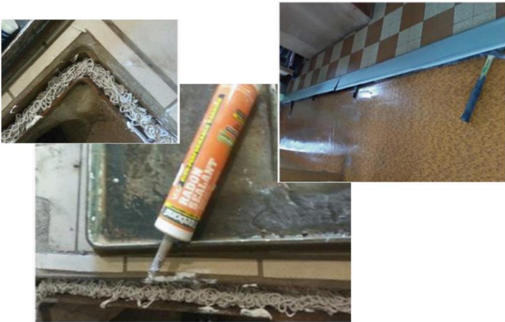
Pose de mastic Anti-radon : plinthes et regards
