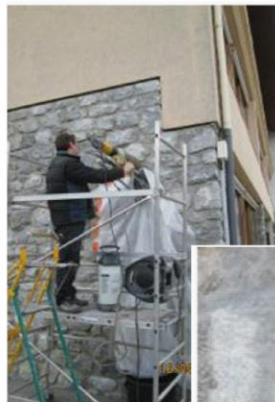
Carottage pour entrée et sortie d'air
