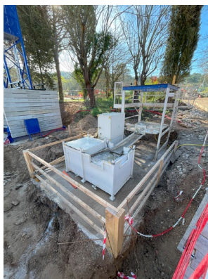
Lavage des bennes à béton
