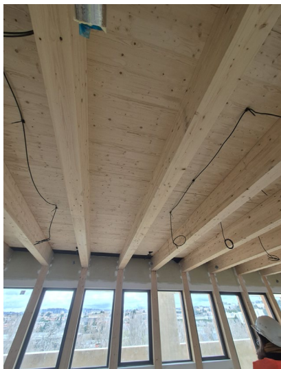
Structure FEG dernier étage partiellement en bois
