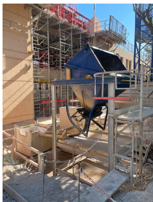
Lavage des bennes à béton
