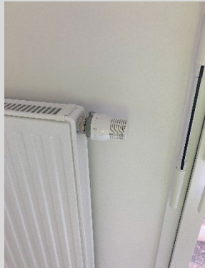
Radiateur avec robinet thermostatique
