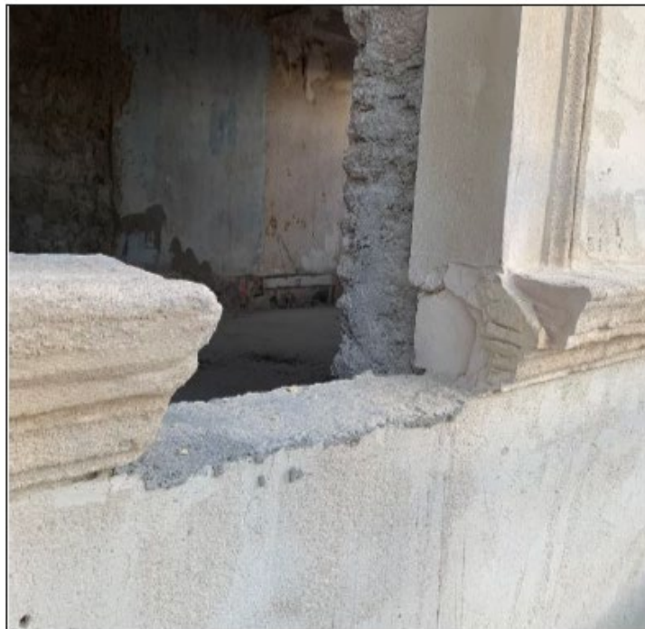
Appui de fenêtre déposé
