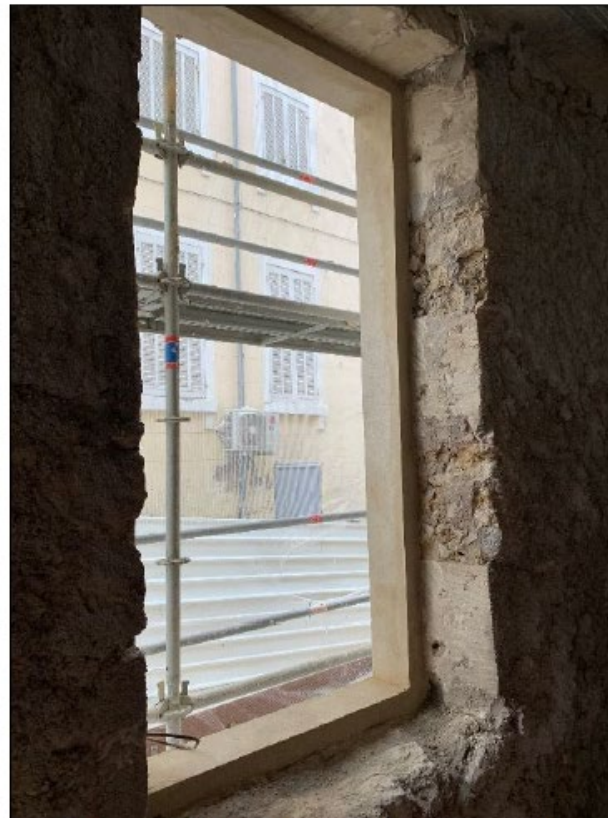
Réalisation de feuillures sur les anciennes baies
