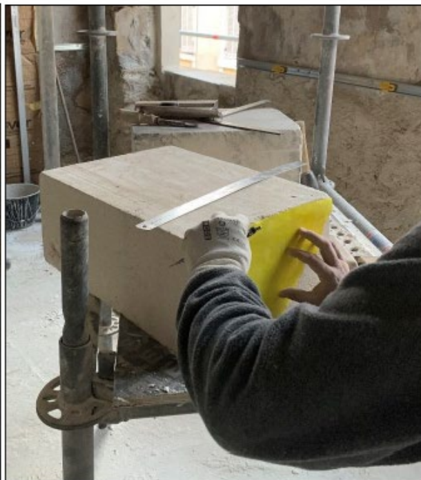
Taille de la nouvelle pierre en remplacement
