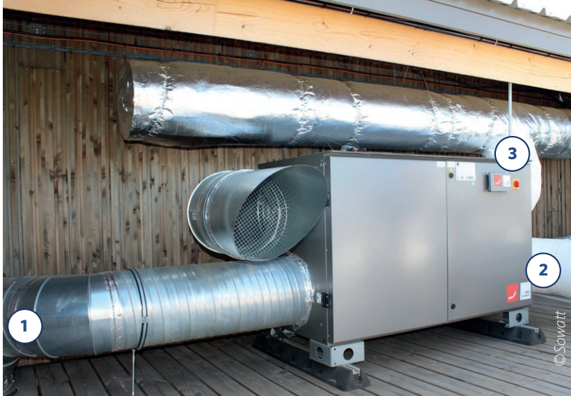
1-Arrivée réseau issu du puits 2-Soufflage 3-Reprise
