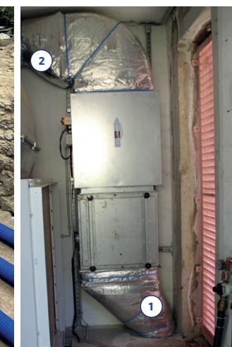
VMC simple flux - 1 : Arrivée du puits - 2 : Soufflage - ©Sowatt
