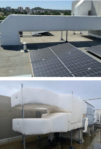
Cheminement et CTA en toiture ©Sowatt
