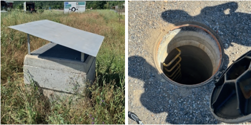
Prise d'air : ouvrage sur mesure permettant la protection à la pluie et aux rongeurs, tout en respectant la porosité demandée.
