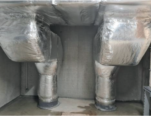
Sortie du puits dans le local technique au R-1 - ©Sowatt
