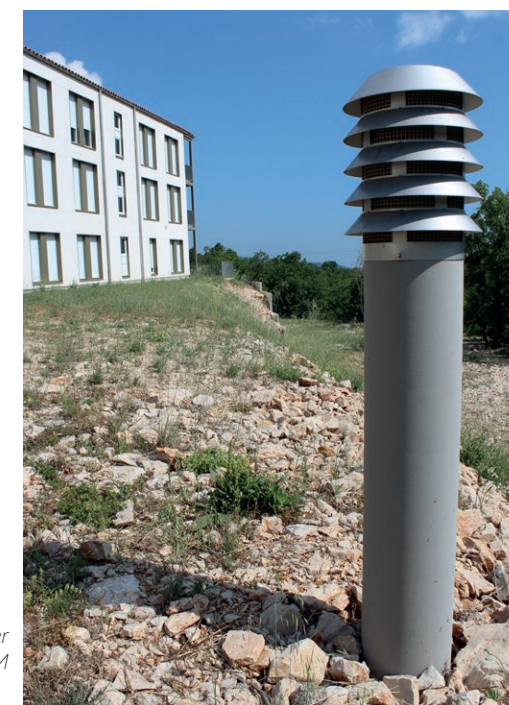
Prise d'air en acier ©EnvirobotBDM
