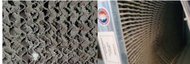
Filtre encrassé déformé par la surpression
