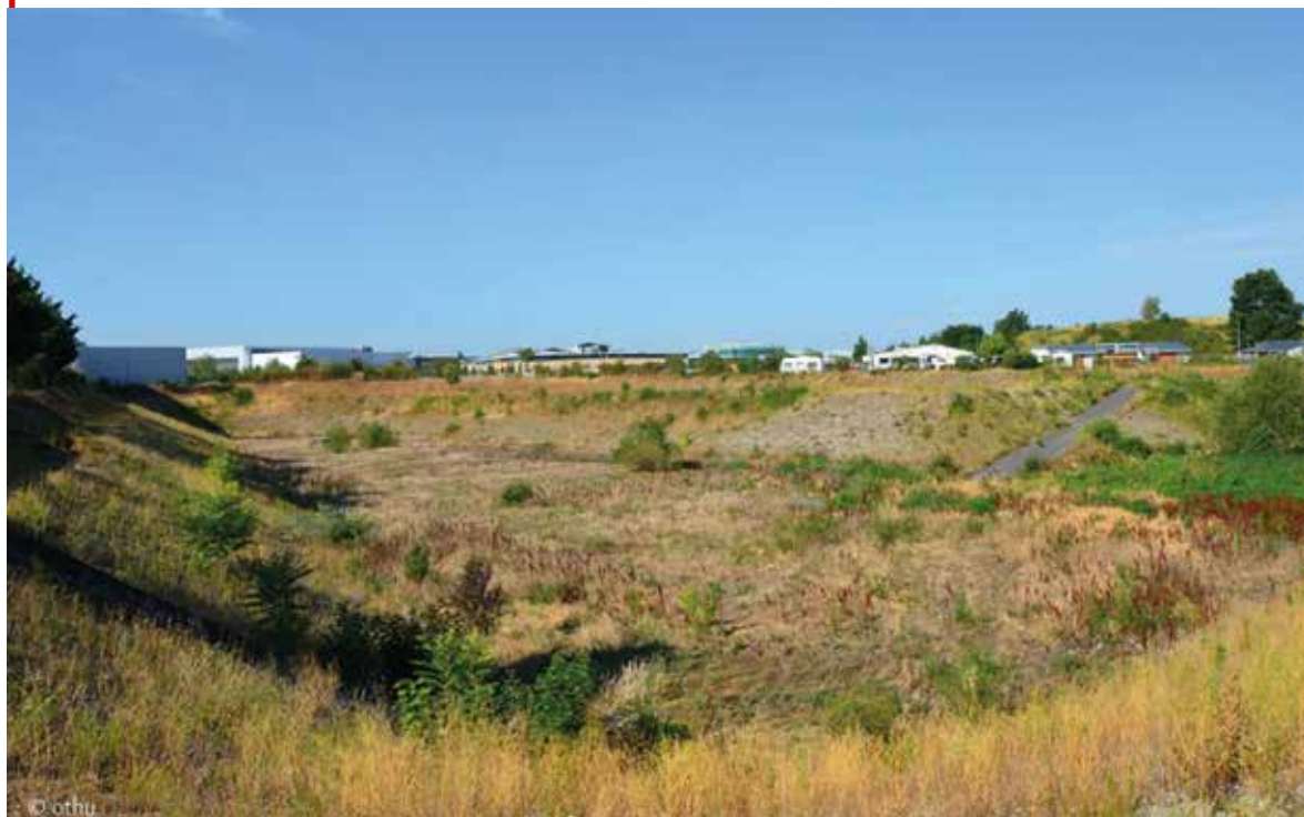
Photo 1a : Bassin d'infiltration centralisé non intégré (Bassin Django-Reinhardt, Chassieu).
