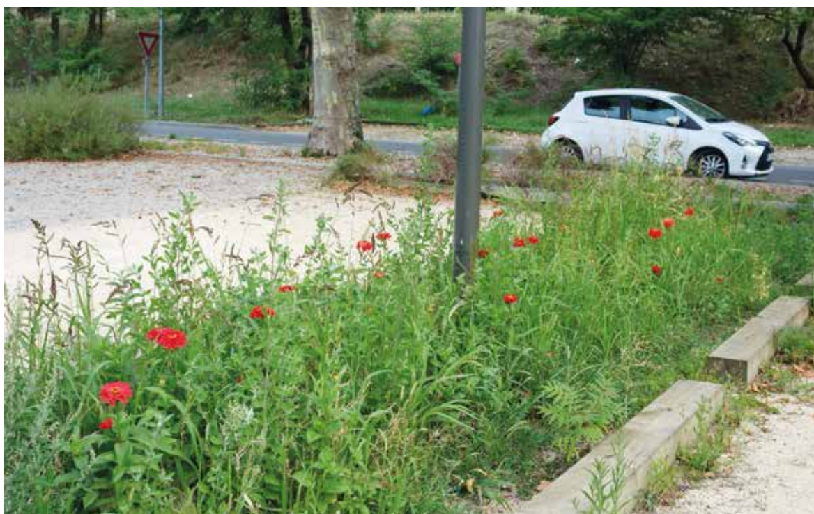
Photo 1 : Noue végétalisée drainant les eaux d'un parking du campus de la Doua à Villeurbanne.
