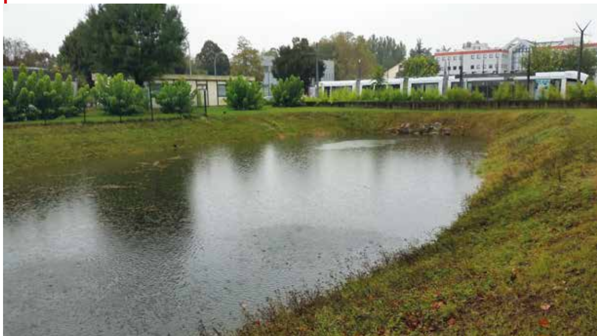
Photo 1b : Bassin d'infiltration centralisé (IUT Villeurbanne).
