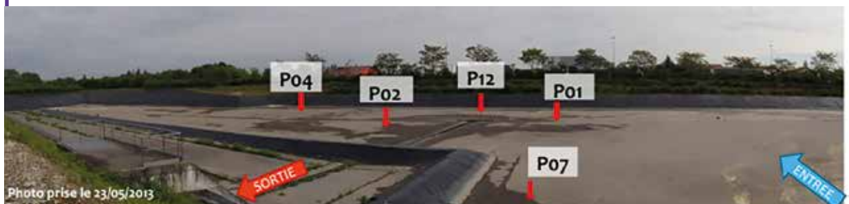
Figure 2 : Hétérogénéité spatiale des concentrations en polluants organiques : photo du bassin de rétention de Django-Reinhard et concentrations en Bisphénol A et Nonylphénol diéthoxylé (NP2EO) (P01 : entrée, P02 : centre, P04 : gouttière/sortie, P07 : sortie, P12 : fosse à hydrocarbures).
