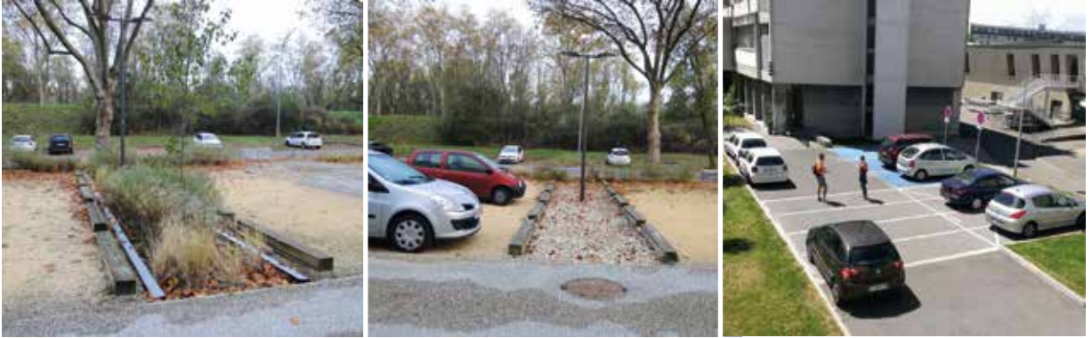
Photo 2 : Vue des trois systèmes instrumentés (de gauche à droite : parking muni d'une noue, parking muni d'une tranchée, parking en chaussée réservoir et enrobé en béton drainant) – Ecocampus Villeurbanne.
