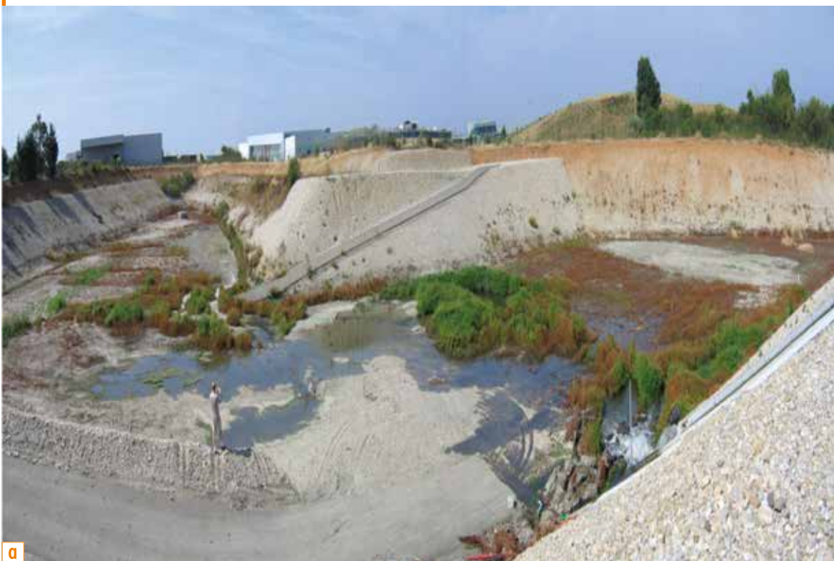
Photos 1 : (a) État de la végétation dans le bassin Chassieu-Django-Reinhardt entre le décolmatage 2004 (en haut) et (b) en 2007 (en bas), en période d'amorce de la diminution du colmatage. (Source : Gonzalez-Merchan, 2012)
