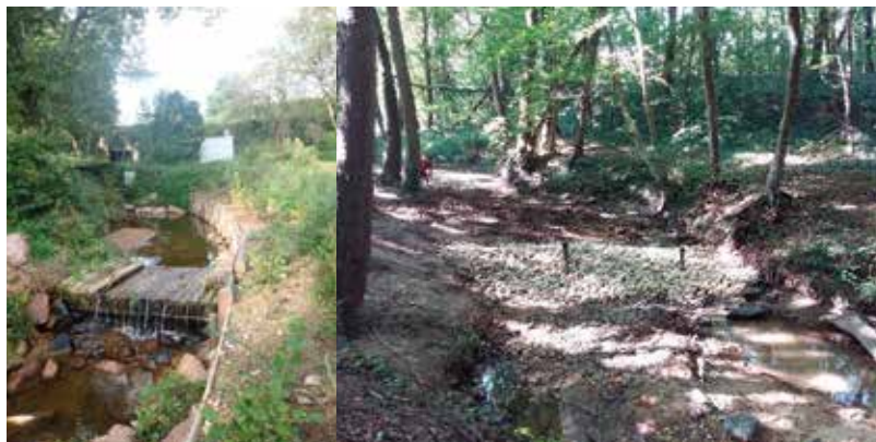
Photo 3 : Dispositifs de barrières filtrantes sur le bassin de l'Yzeron : à gauche ancien (2005) seuil poreux sur la Chaudanne à Grézieux-la-Varenne ; et à droite nouveau (2020) seuil poreux (épi poreux) sur le Ratier (source: P. Breil INRAE).
