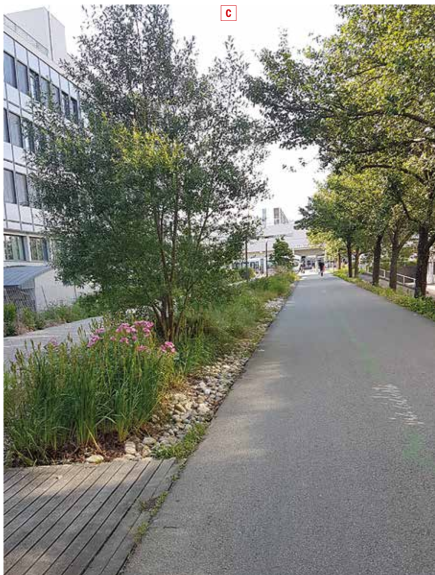
Photos 1c et 1d : Noues d'infiltration reprenant les eaux de pistes cyclables et voies piétonnes (Campus INSA, Villeurbanne).
