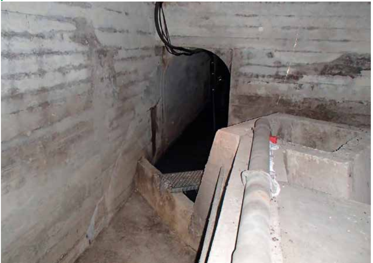
Photo 1 : Géométrie du déversoir d'Écully (source : Momplot, 2014).
