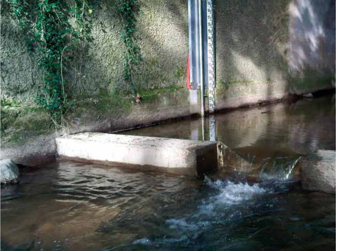
Photo 1 : Station hydrométrique du Ratier à Saint-Genis les Ollières sur le site OTHU du bassin versant de l'Yzeron. La station est équipée d'un seuil béton et d'un déversoir triangulaire pour une bonne qualité de mesure des bas débits (source : Mickaël Lagouy, INRAE, 2011).
