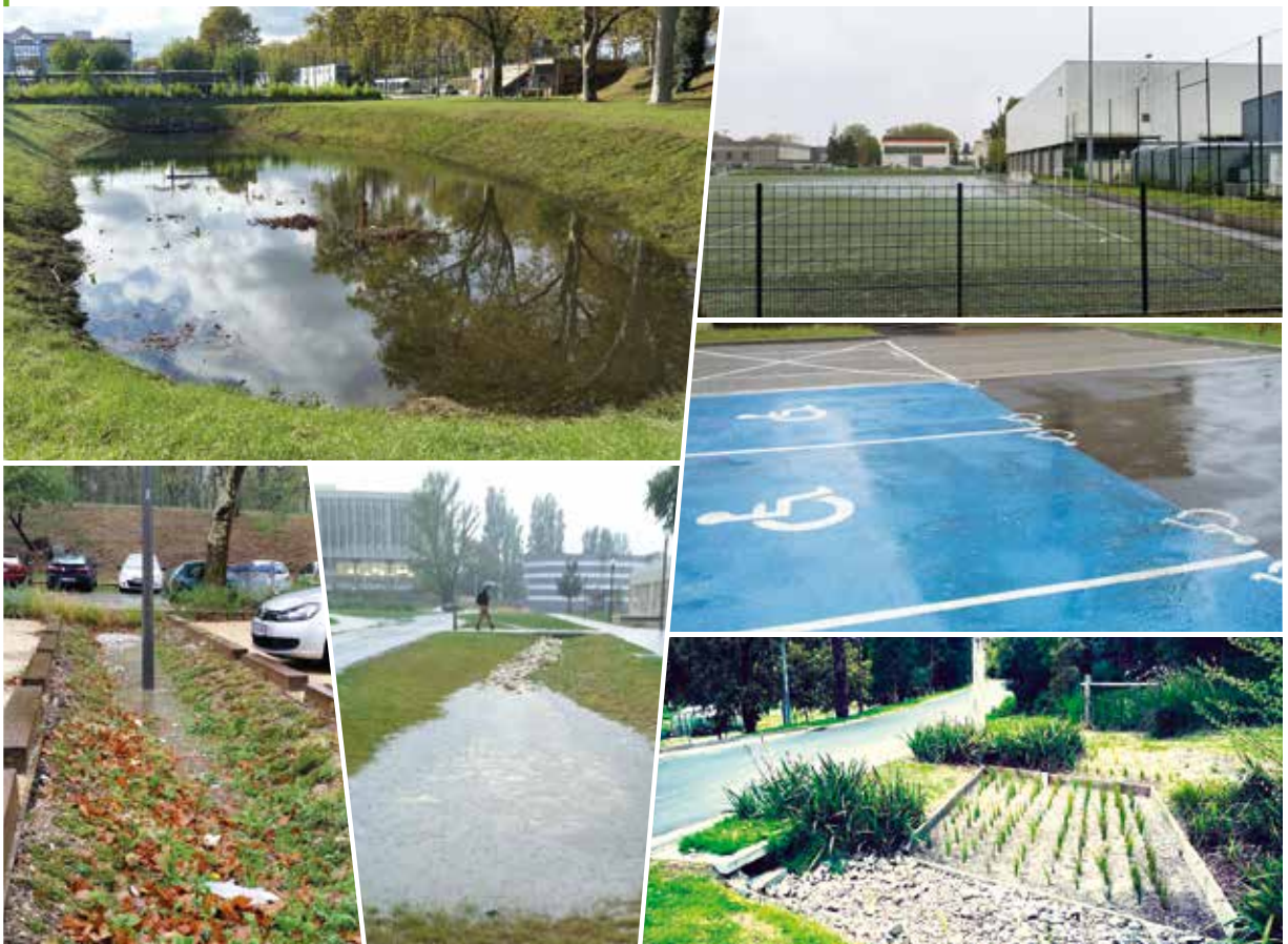
Figure 2 : Exemples d'aménagements de gestion des eaux pluviales : noues, bassin d'infiltration, jardin de pluie, parking à chaussée poreuse, et bassin d'infiltration servant de terrain de football (source: F. Cherqui).
