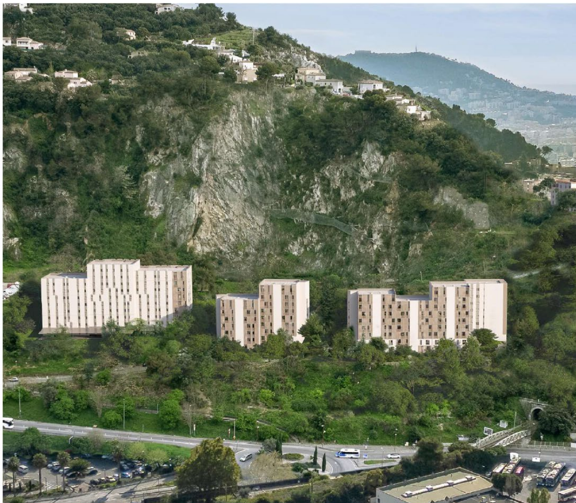
VUE D'ENSEMBLE DE LA RÉSIDENCE MONT-GROS RENOVÉE
