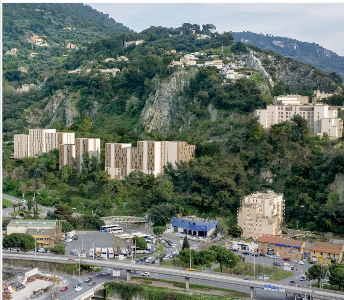
VUE D'ENSEMBLE DES 3 RESIDENCES RENOVEES
