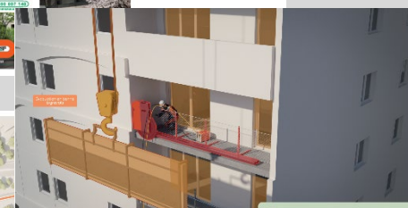
Étape 7: Dépose de l'élément à l'aide de la grue Dépose de la sac
