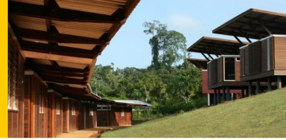
Les espaces de circulation sont ventilés en partie centrale par un système mixte de ventelles et d'écopos de toiture.
