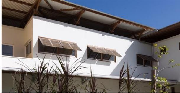
Les unités de vie combinent une bonne protection solaire avec une grande porosité des façades, un recours important aux matériaux biosourcés (bois de Guyane certifié PEFC, briques de terre crue stabilisée) et enfin des systèmes performants (brasseurs d'air). La végétation participe au confort des espaces extérieurs.
