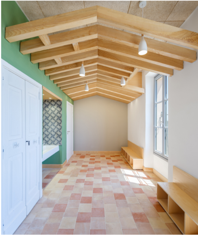
PORTES ET CARREAUX DE CIMENT REEMPLOYES
