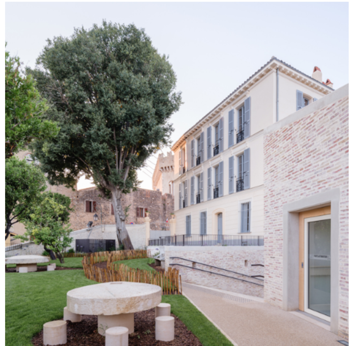
Crédit : Ville de Cagnes-sur-Mer / Plò architectes
