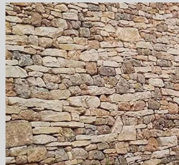
Matériau sourcé à 65km du projet (Vaugines)
