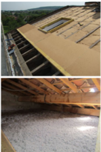
Exemple d'isolation sous (sarking) et sur toiture
