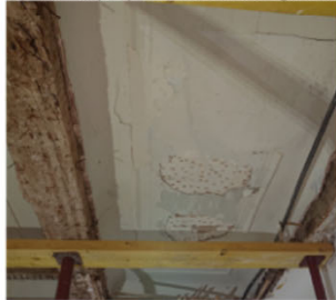
Plancher R+1 (plâtre sur enfustage et poutre)
