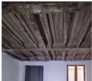
Plancher étage courant (poutre - enfustage...)
