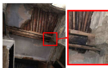
Figures 43 (a et b) – Renforcement sommaire en bois d'une poutre et attaque parasitaire de l'about de poutre Etanchéité de la toiture terrasse n'assurant pas son rôle
