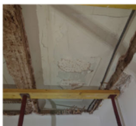
[13] Faux-plafond plâtre mouluré entre poutre R+1
