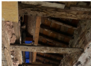
Toiture d'attique : poutre-chevrons-voliges bois
