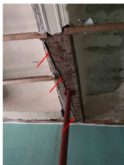
Figure 20 – fissure importante (gerce ?) sur poutre
