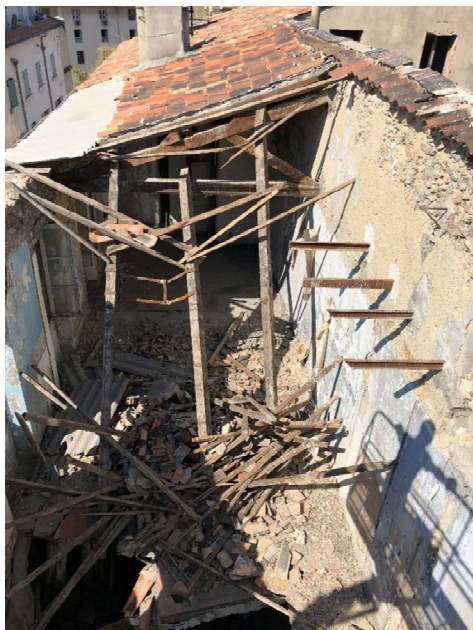
Effondrement de couverture constaté en 2020 à la reprise des études. Purge et mise en place d'une couverture provisoire
