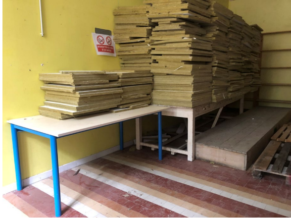
Stockage des dalles de faux-plafonds pour réemploi
