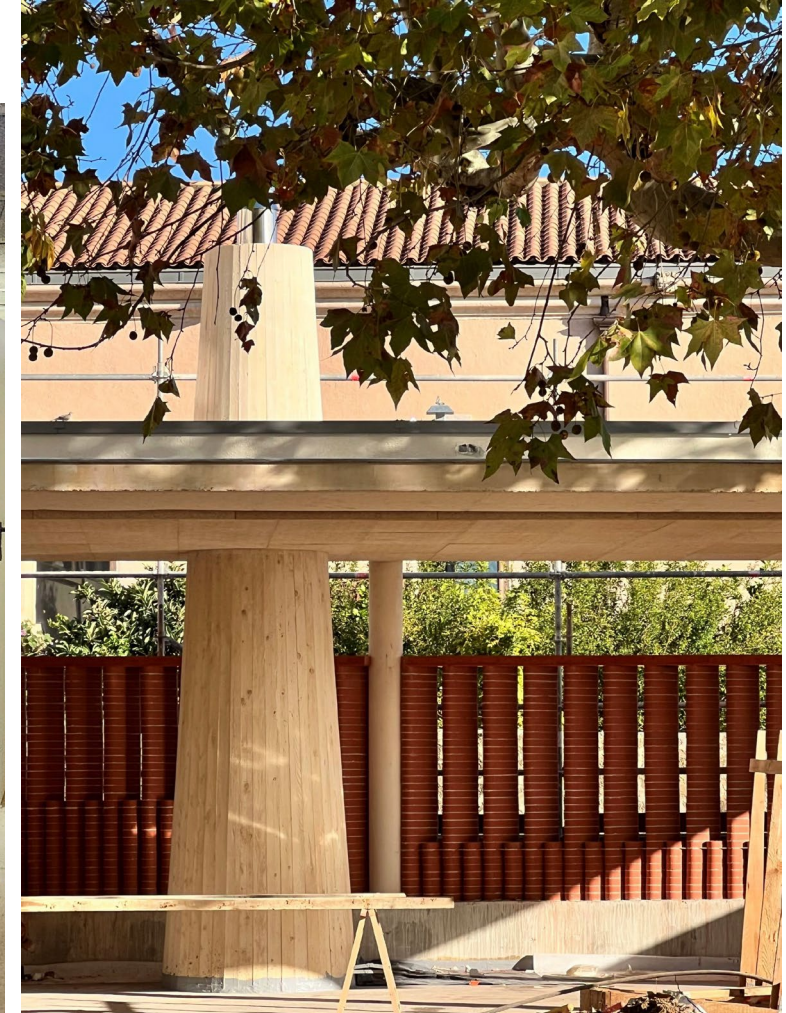
Conduit de cheminée de la chaufferie bois (NSL Architectes Ingénieurs)
