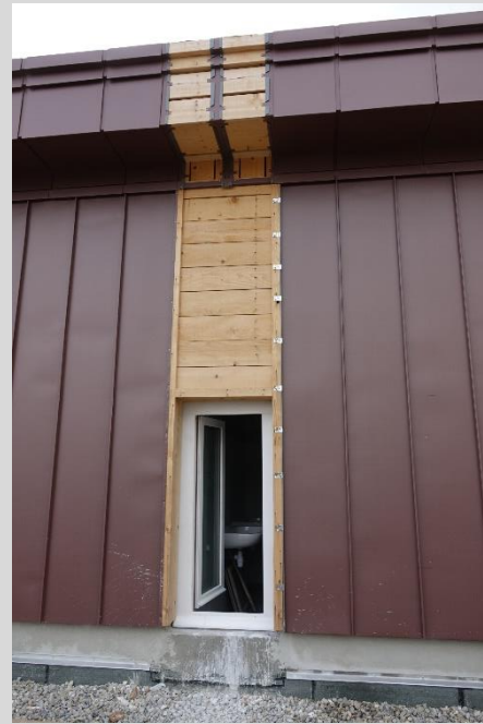
Support bois pour bardage toiture Zinc
