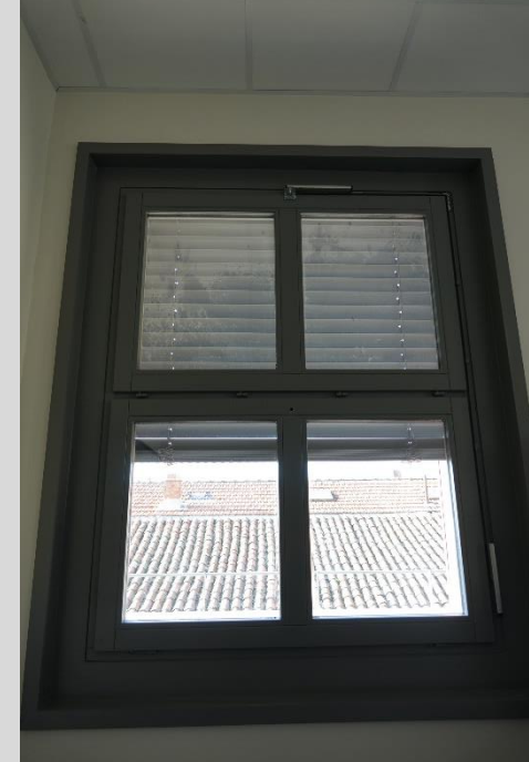
Façades Ouest et Sud : Brise Soleil Orientable
