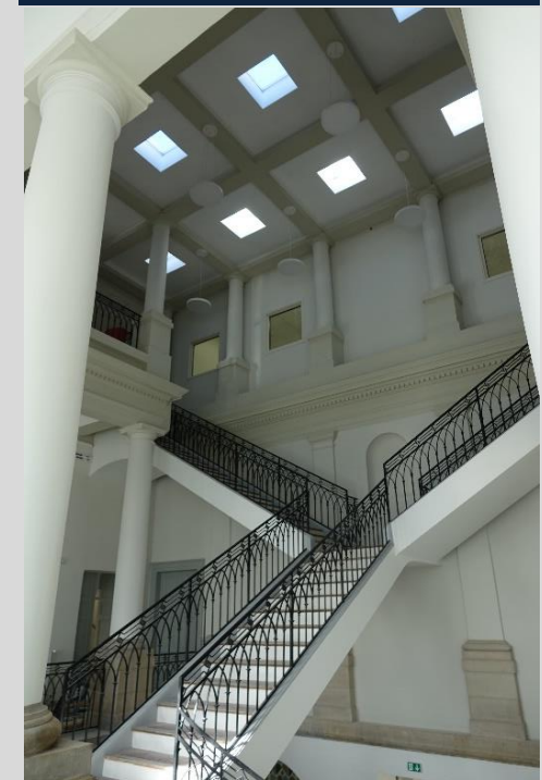
Renfort ciblé de la volée supérieure de l'escalier central
