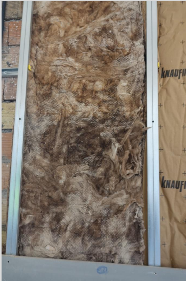
Cloison : isolant laine de verre Ecosé®
