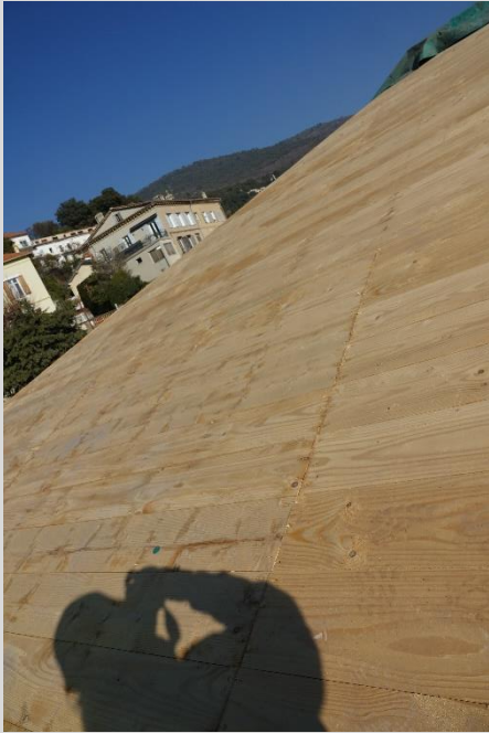
Support bois pour bardage toiture Zinc
