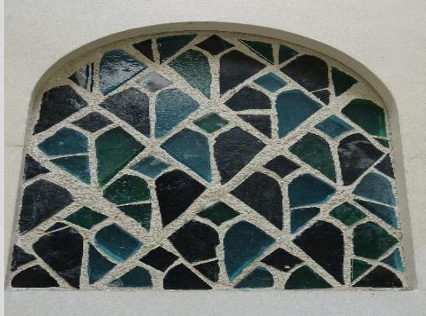
Restauration des vitraux
