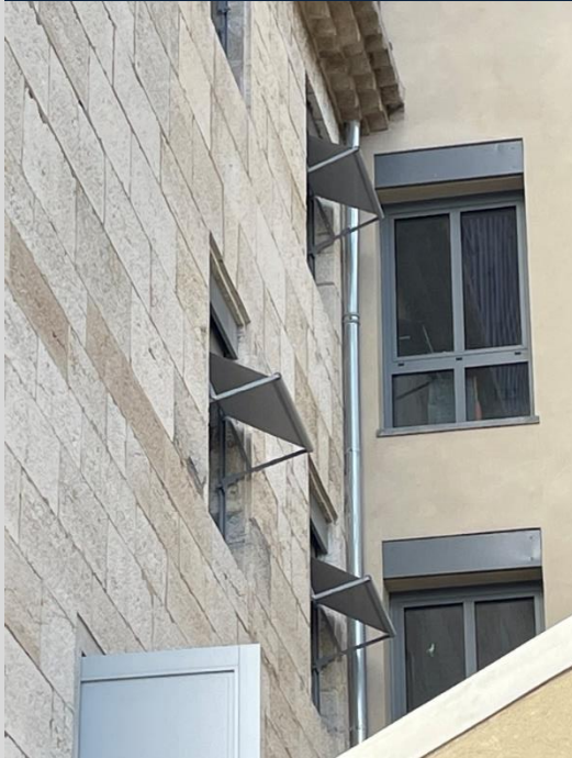
Façade Est : Store toile à projection Griesser Modèle Galléria
