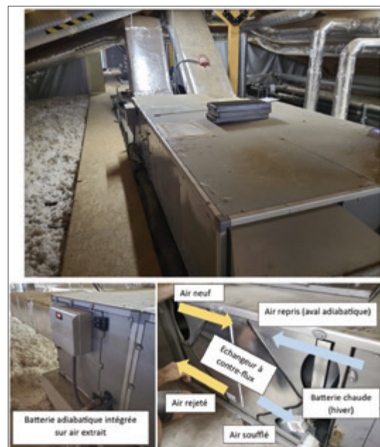
Échangeur à contre flux (ECF) installé dans le local technique - Pays d'Aix
