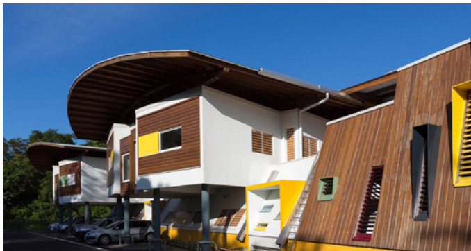
IME Rémire-Montjoly, architecte : Acapa
