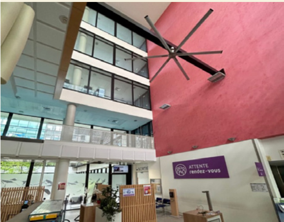
CPAM, brasseur : Mise en place de brasseurs à pales dans le hall d'accueil du siège de la CPAM à Annecy
