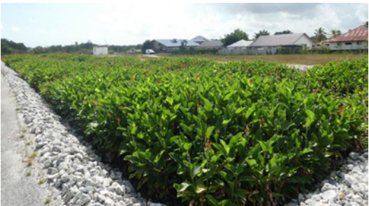
Systèmes d'assainissement collectifs et/ou semi-collectifs par bassins filtrants sur l'OIN Margot. Crédit photo : Franck Brasselet et Frédéric Pujol
