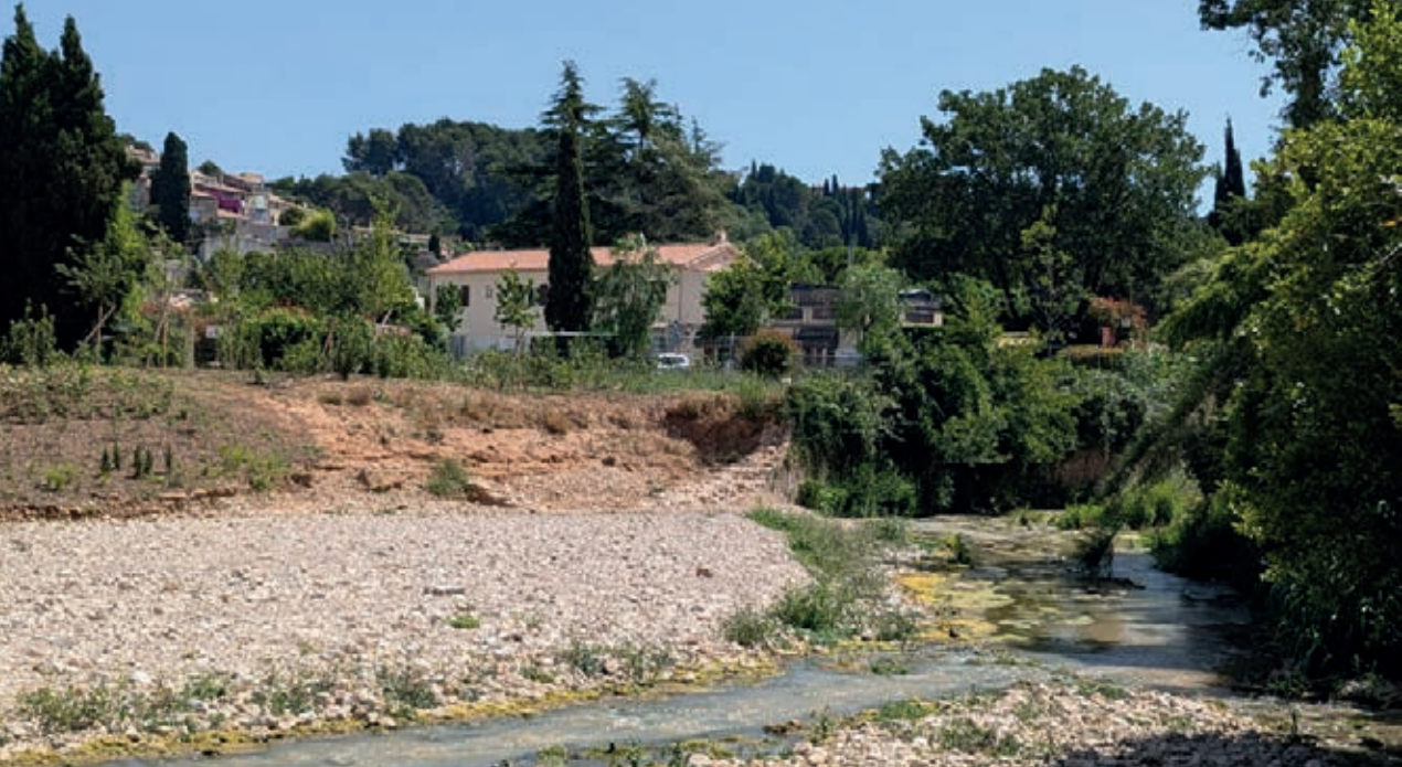
Photo des travaux d'aménagement et de renaturation des berges de la Brague, © Sacha Lenzini 2024
