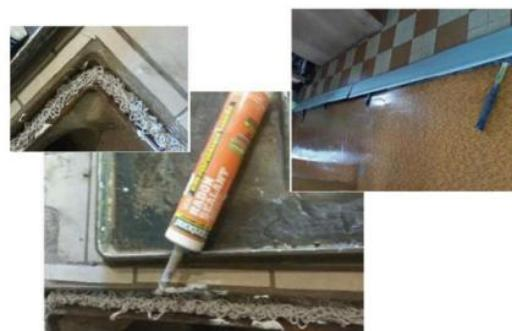
Poser de mastic Anti-radon : plinthes et regards
