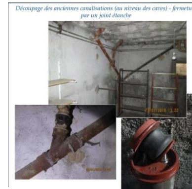
Découpage des anciennes canalisations (au niveau des caves) - fermeture par un joint étanche
