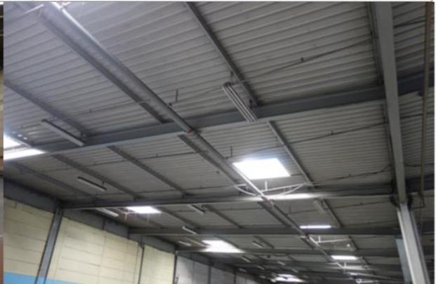
Ressources principales : charpente métallique (boulonnée), pannes acier, toiture en bac acier, bardage acier isolé, lanternaux, cloisons en béton cellulaire, équipements divers...
