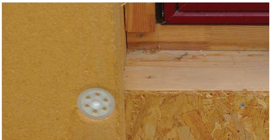
Cheville équipée d'un bouchon de polystyrène placé sur la tête
