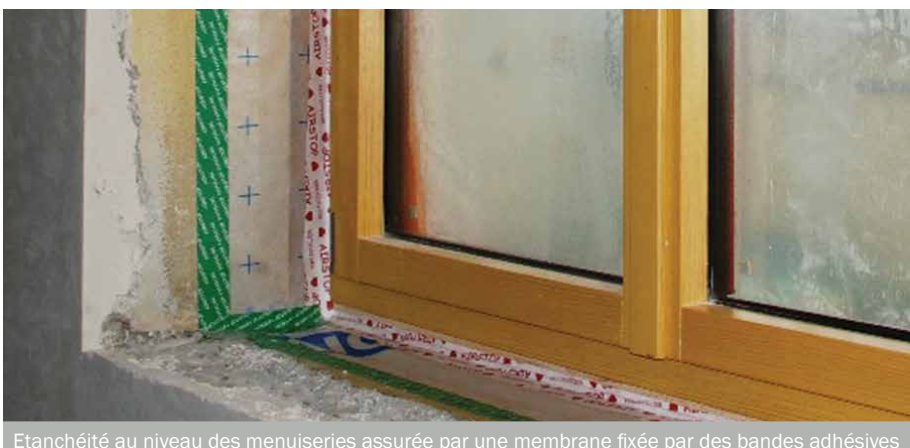
Etanchéité au niveau des menuiseries assurée par une membrane fixée par des bandes adhésives
