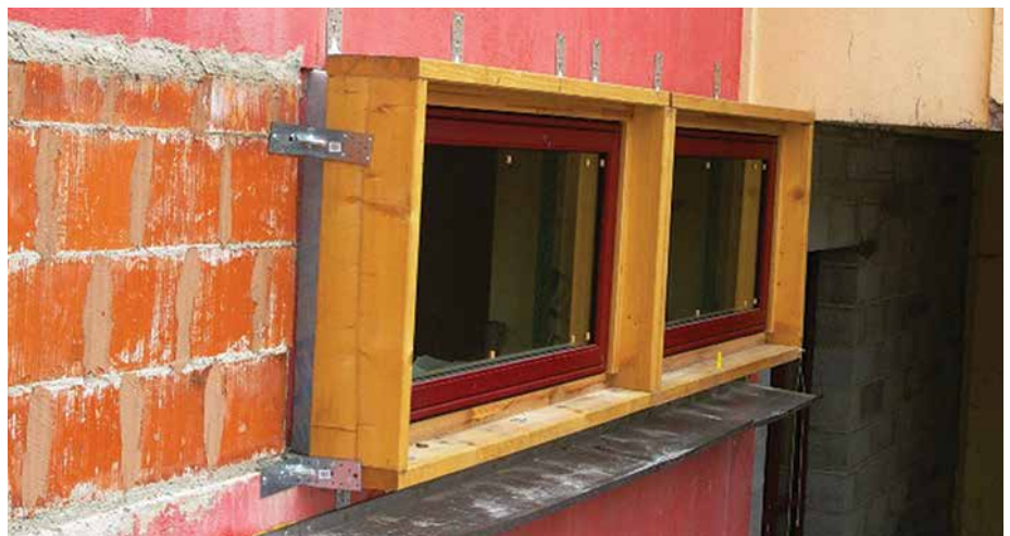
Menuiseries posées en tunnel entre les montants de l'ossature de l'isolation par l'extérieur. Raccord visible entre la menuiserie et le mur intérieur réalisé à l'aide d'une membrane.
