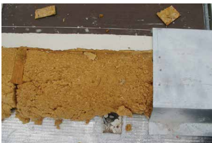
Acrotère au moment de la pose des couvertines
