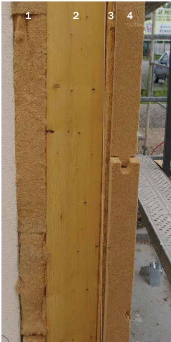
Vues transversale et de face du complexe isolant avant l'application de l'enduit Sont visibles : 1. laine de bois 2. ossature bois 3. OSB 4. panneau de fibre de bois
