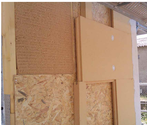
Complexe isolant en cours de montage (© Li Sun Environnement)
