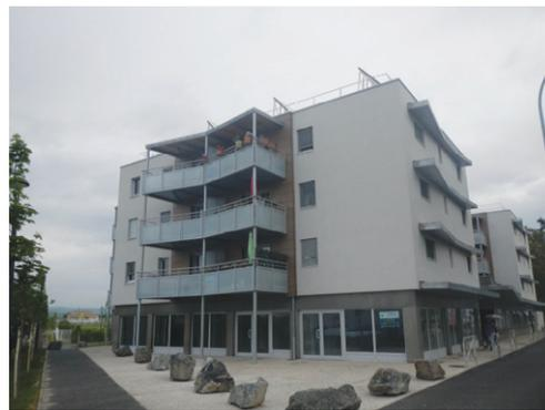
Résultat de l'application de 3 nouvelles réglementations : bâtiment BBC (ou RT 2012) avec ITE et vêtture (+ panneau solaire en toiture).
