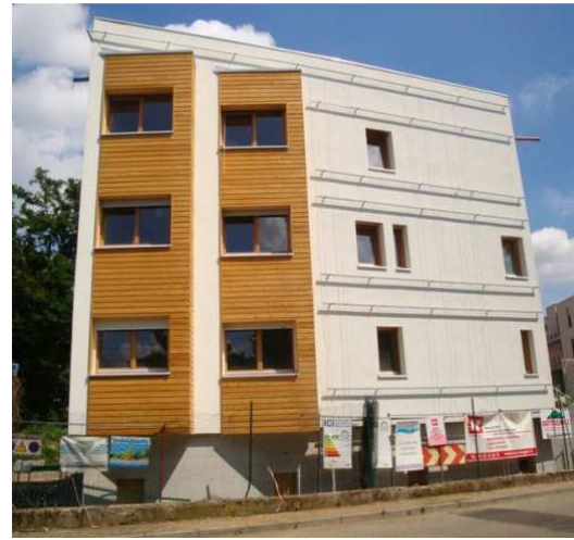
Chantier Eco-Logis, le 04/08/2010
