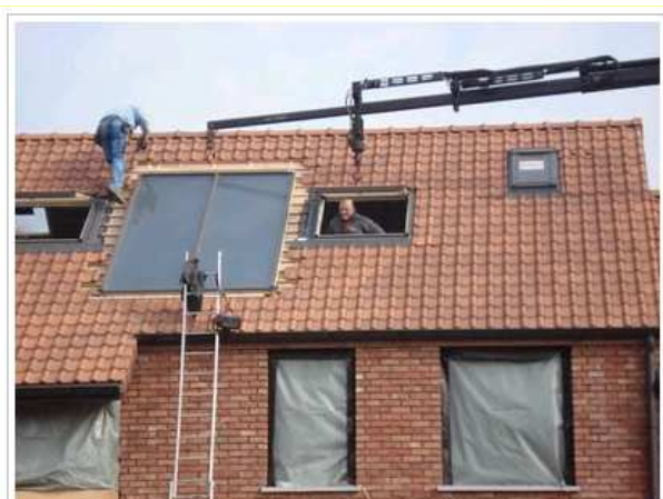
Pose des panneaux solaires thermiques
