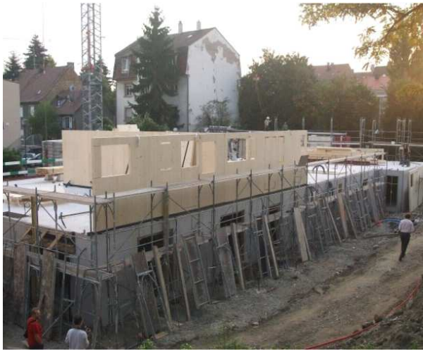
Chantier Eco-Logis, le 22/09/2009
