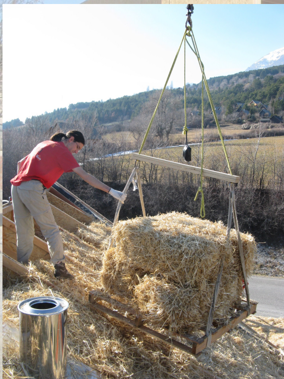
La paille sera ensuite couverte de panneaux de fibre de bois dense de 16mm, en guise de pare-pluie
