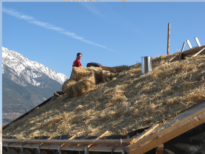
Isolation de la toiture avec des bottes de paille de seigle de Châteauroux
