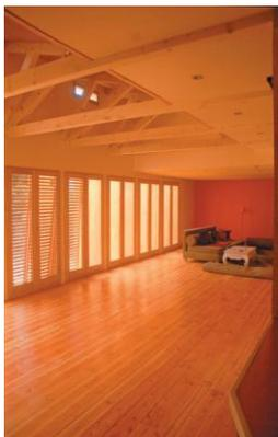
La nature des matériaux est favorable à un bon confort acoustique : les plaques de Fermacell, composées de fibres de papier recyclé (cellulose), de gypse et d'eau apportent une qualité phonique avec un affaiblissement acoustique de 40 dB minimum. Le plafond sous la toiture végétalisée est en planches clouées. Ces 2 éléments apportent une amélioration de la qualité phonique par l'absorption des sons.
