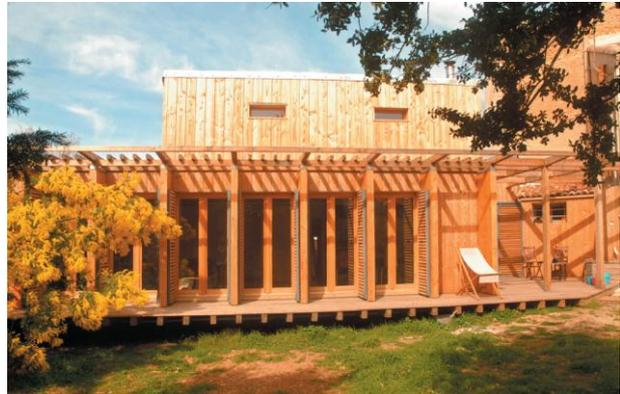
Dans ce projet, le choix des matériaux est d'origine local : du douglas en bardage et plancher intérieur et du mélèze en menuiserie extérieure. En ossature, l'architecte a utilisé de l'épicéa classe 2.
