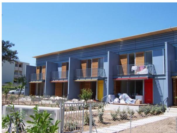
La solution constructive en bois retenue pour ces logements sociaux n'est pas conventionnelle : elle comprend une structure à trame d'un mètre entre montants et des panneaux de fibres multifonction non-structuraux à la place de panneaux en OSB. Le contreventement est assuré par des colombages, ce qui renoue avec les anciennes traditions de construction en bois.
