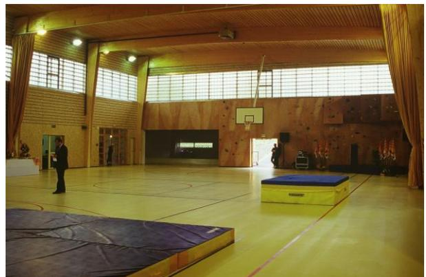
Pour ce bâtiment sportif, l'utilisation du bois est omniprésente : pour la charpente lamellée collée en épicéa, la vêtue extérieure en clins de mélèze et les parements intérieurs de l'aire d'évolution et du mur d'escalade. La couverture est réalisée en cuivre.
