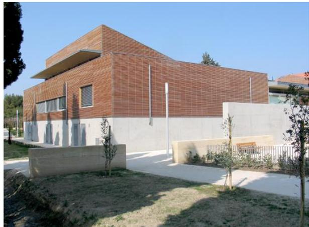
L'ensemble du bâtiment est réalisé en structure bois avec une charpente sous-tendue pour supporter la toiture de la salle polyvalente dont la portée libre est de l'ordre de 18 m. La charpente se compose d'arbalétriers en bois reliés au faîtage et d'éléments de sous-tension constitués de tirants métalliques et de bracons en bois en forme de fuseau.
