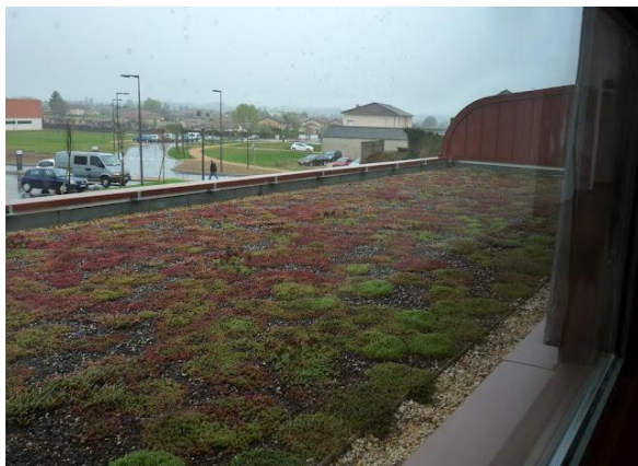
Toiture végétalisée sur la toiture de l'extension en façade Est
