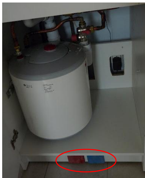
Commande bout de pied (à gauche) et chauffe-eau visible sous l'évier (à droite)
