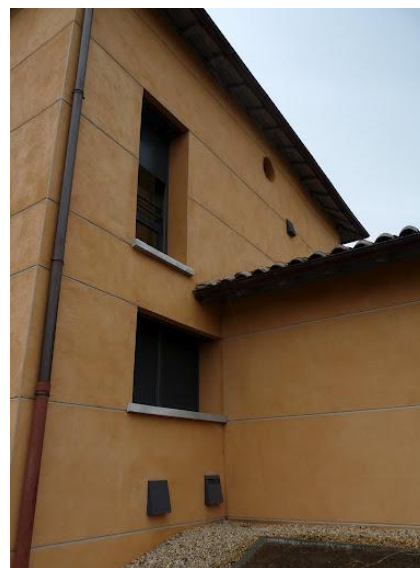
Isolation du pisé par de la ouate de cellulose + enduit à la chaux
