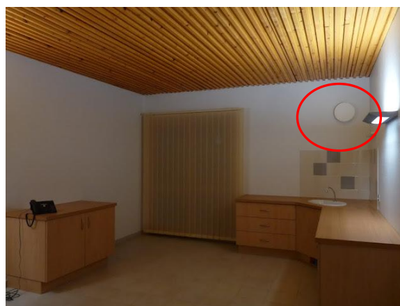
Boîtiers visibles en extérieur et en intérieur
