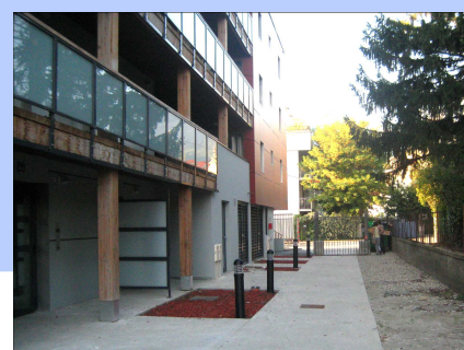
Maître d'ouvrage : Bouygues, Maître d'œuvre : Ph. Meunier
