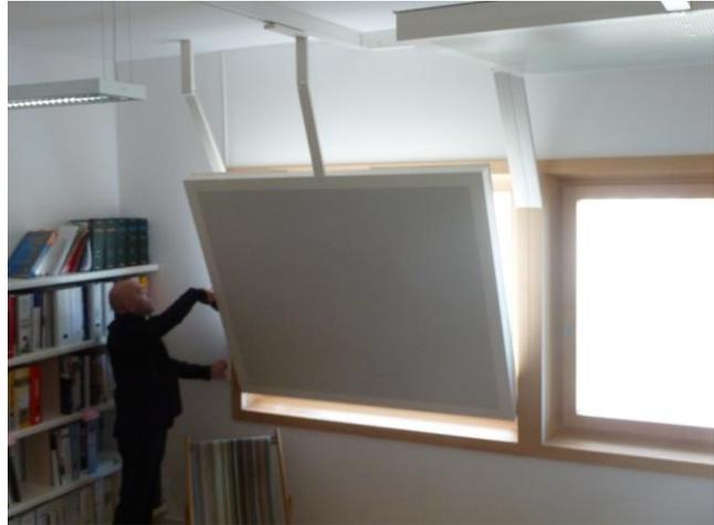
Sur les 22 bouchons thermiques du niveau, 4 sont défectueux actuellement, en lien avec les courroies ... Il faut 45 secondes pour en lever ou en baisser un ce qui est difficile à gérer pour le dernier qui part le soir et le premier arrivé. La réglementation qui s'applique est celle des portes de garage, c'est pourquoi il est prévu une commande par bouchon.
