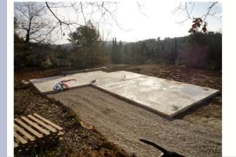
Pas de vide sanitaire mais un radier de 25 cm de béton isolé par l'extérieur par du polystyrène expansé
