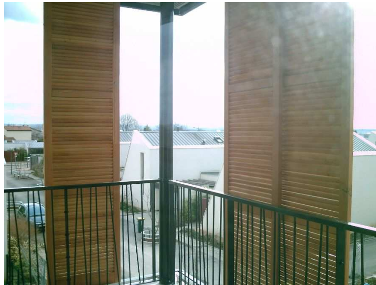
Protections solaires mobiles pour les balcons
