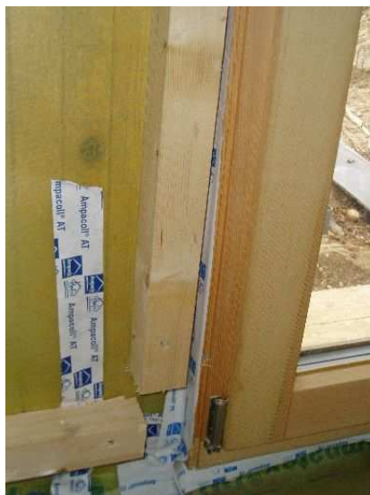
Étanchéité à l'air des menuiseries
