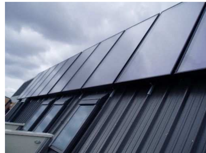
24 m 2 de capteurs solaires thermiques par bâtiment, orientés Sud
