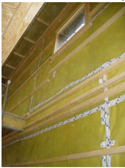
Jonctions étanches à l'air des panneaux livrés par Ossabois
