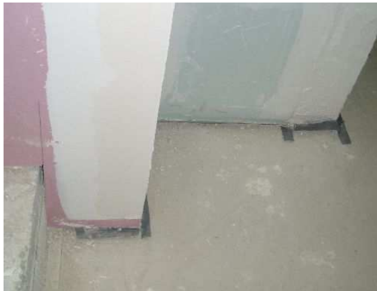
Rupteur de ponts thermiques entre le volume chauffé (logements, chaufferie,...) et non-chauffé (coursive)
