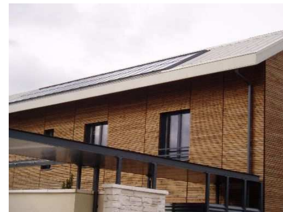
Capteurs photovoltaïques et solaires thermiques
