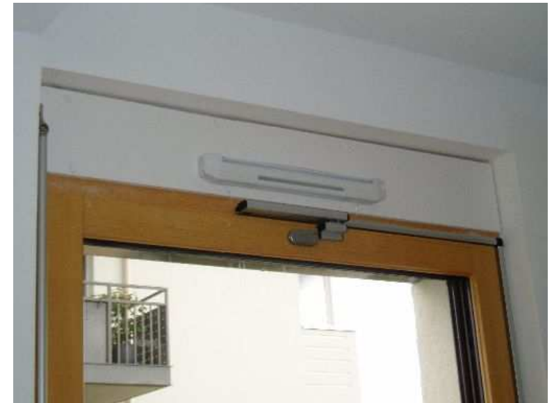
Prise d'air dans un logement
