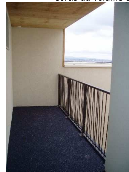
Palier sorti du volume chauffé
