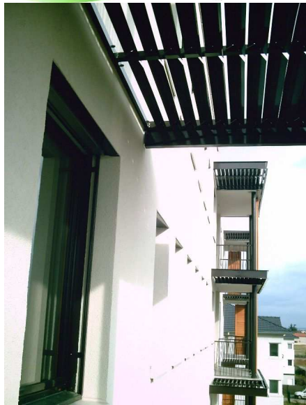
Brise soleil et protections solaires mobiles sur les balcons
