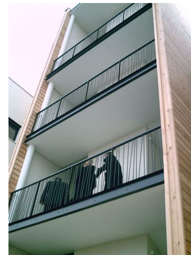
Cage d'escalier et ascenseur sortis du volume chauffé
