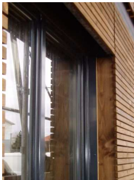
Isolation par l'extérieur et bardage bois, fenêtre triple-vitrage, menuiserie bois-alu
