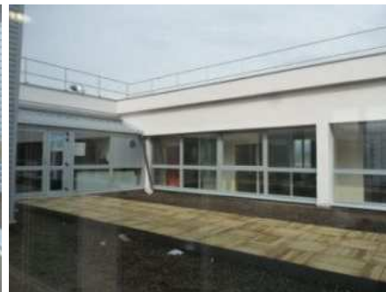
R+3 : couloir et patio central
