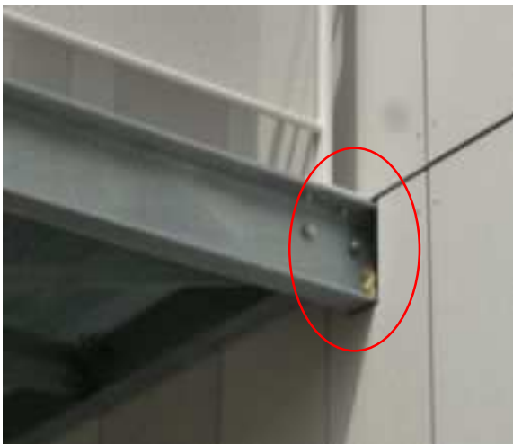
Fixations de l'escalier de secours et du auvent
