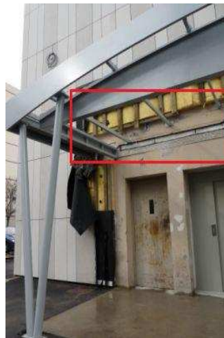
Fixations de l'escalier de secours et du auvent
