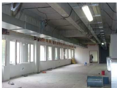
Cheminement des gaines de ventilation dans les bureaux du R+2
