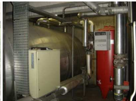
Ancienne chaufferie en sous-sol
