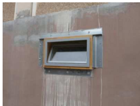
Fenêtre du R-1
