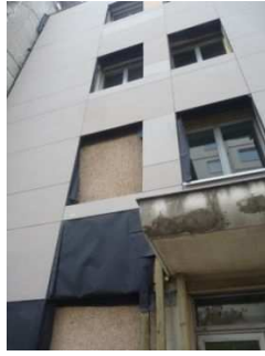
Certaines surfaces ne sont pas isolées car en attente de percement de fenêtres
