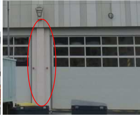
Poteau entre les portes motorisées
