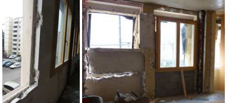
Dépose des anciennes fenêtres
