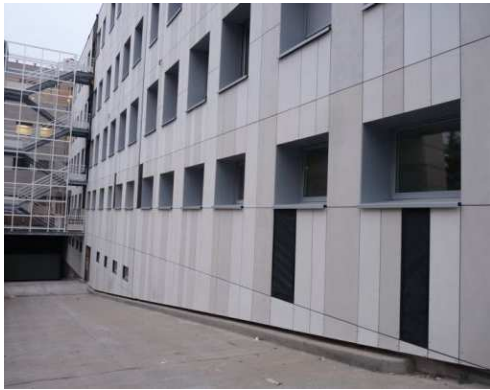
Rampe d'accès au sous-sol
