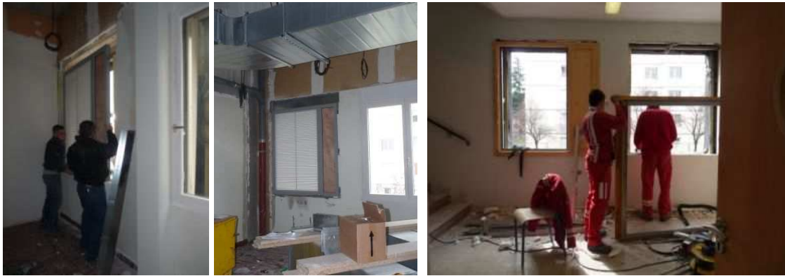
Mise en place des fenêtres
