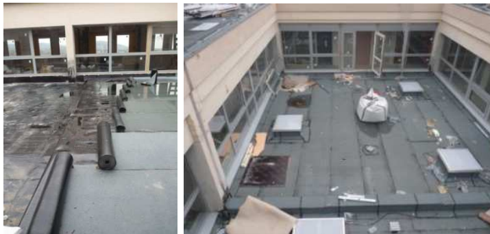
Etanchéité du patio
