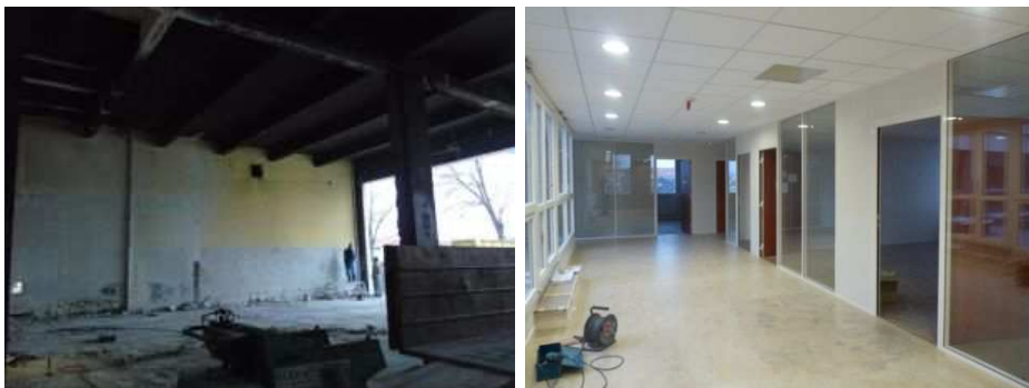
Au 31/01/11, alors que le RDC est en phase de démolition, les finitions sont en cours au R+3.
