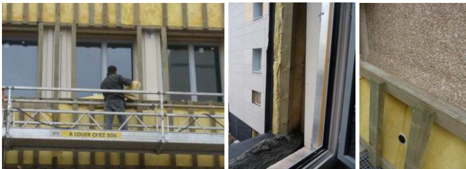
Mise en place de l'isolant derrière les montants bois
