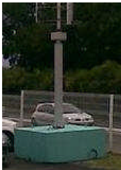
Fondation hors sol et haubanage permettent de faciliter l'implantation (Source : mercinat.com et lewebpedagogique.com)
