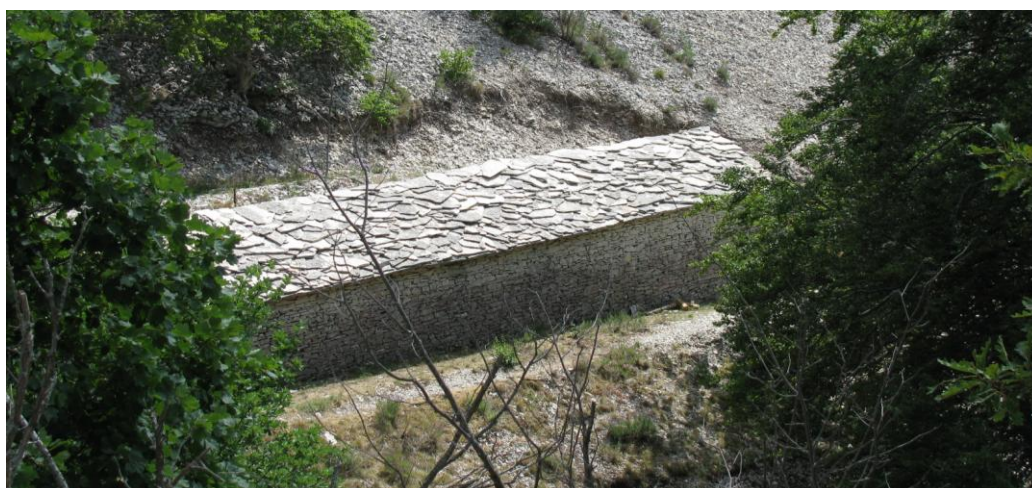
Réalisation par Petra Terra Scop d'une couverture lauze en montagne de Lure Photo : Estelle Pachout-Delahaye
