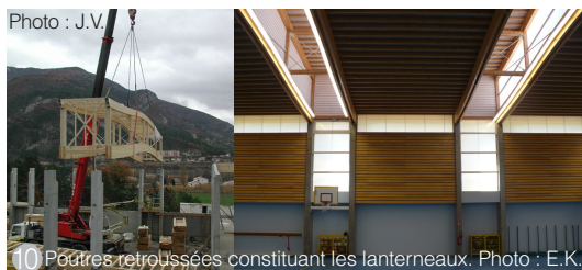
10 Poutres retroussées constituant les lanterneaux. Photo : E.K.
