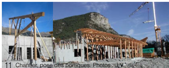
11 Chantier, pose des portiques. Photos : J.V.
